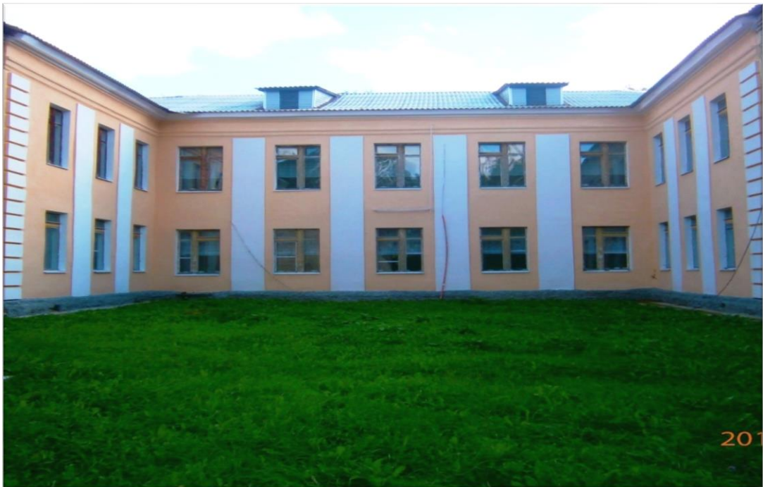
«Наш фасад прекрасен на взгляд» (Капитальный ремонт фасада внутреннего двора). Спонсор Душин Е.В.
